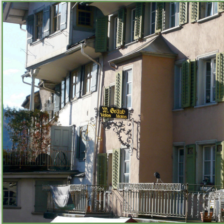
Vor dem Umbau: Das Doppelhaus in Lichtensteig zeigt in seiner ursprünglichen Form die typische «Schrulligkeit» der Altstadt. Auch im Inneren war das Haus voller Kuriositäten und Eigenheiten, die es nach Möglichkeit zu erhalten galt.
